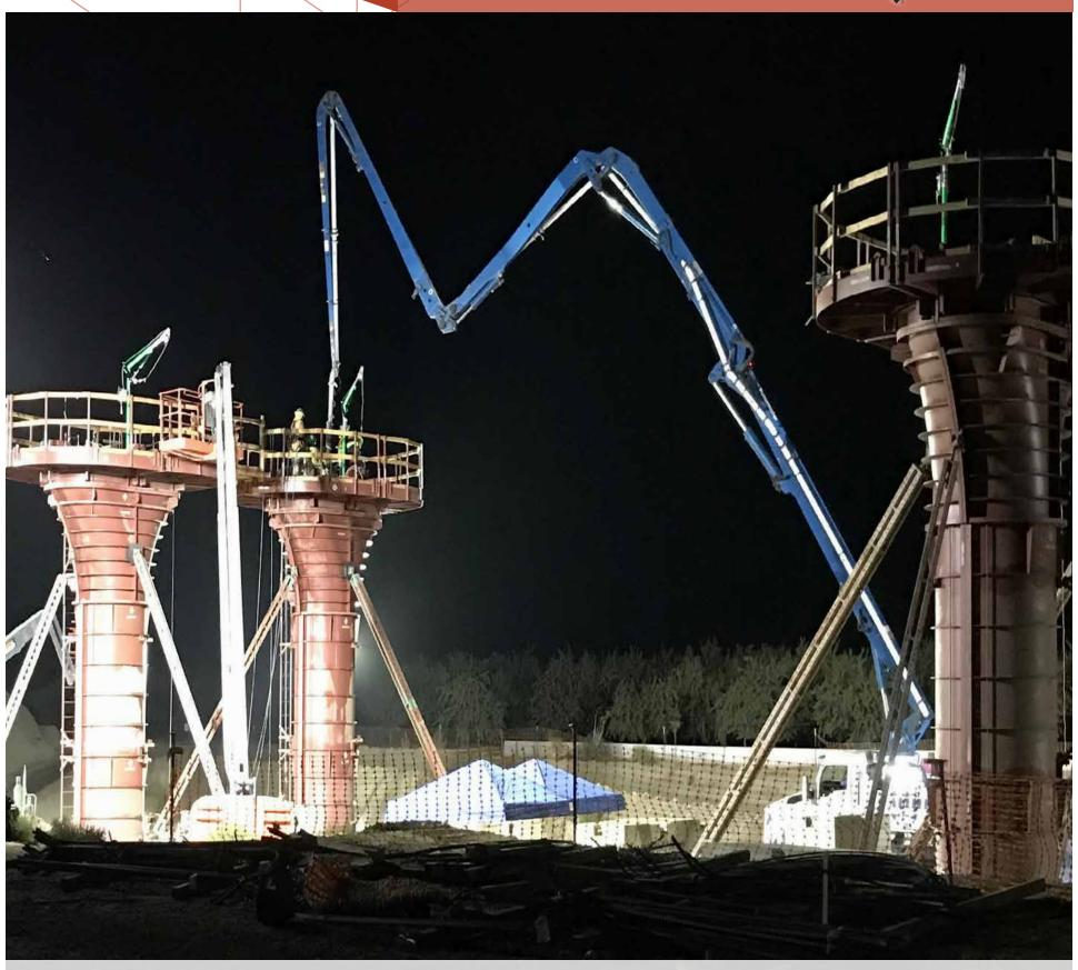
SHOWN ABOVE: SYMONS SOLDIER BEAM AND CUSTOM FORMS ARE UTILIZED ON THE CALIFORNIA HIGH SPEED RAIL SYSTEM PROJECT
